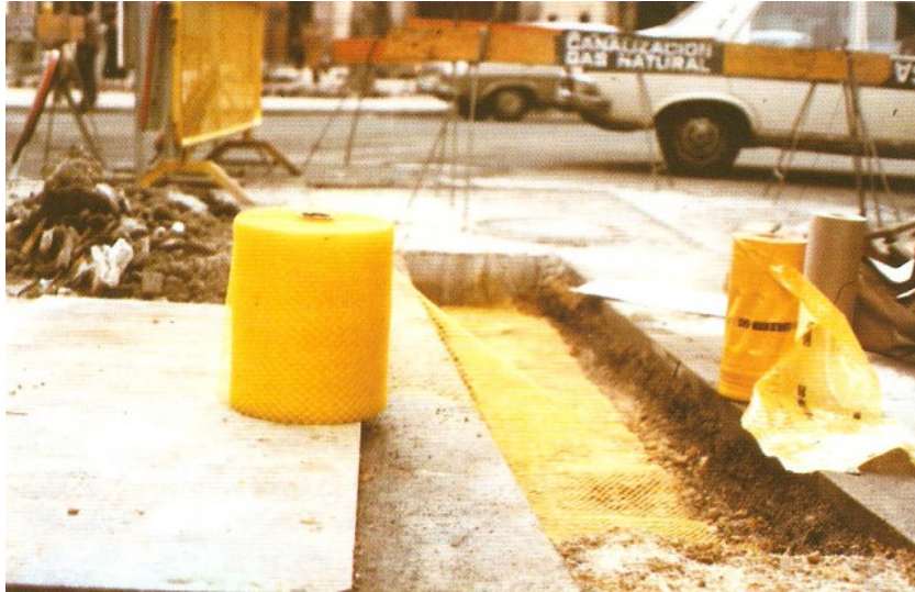
Fig. 5.12 Señalización de tubería. Banda y malla
