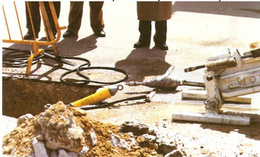
Fig. 5.11 Perforación dirigida. Final de instalación de tubería
