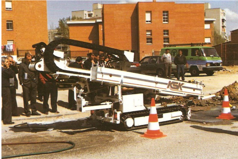
Fig. 5.8 Perforación dirigida. Torre de perforación
